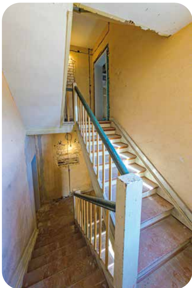
Auch wenn der Hausflur derzeit noch fast so aussieht wie vor dem Umbau, wird auch dieser saniert.
