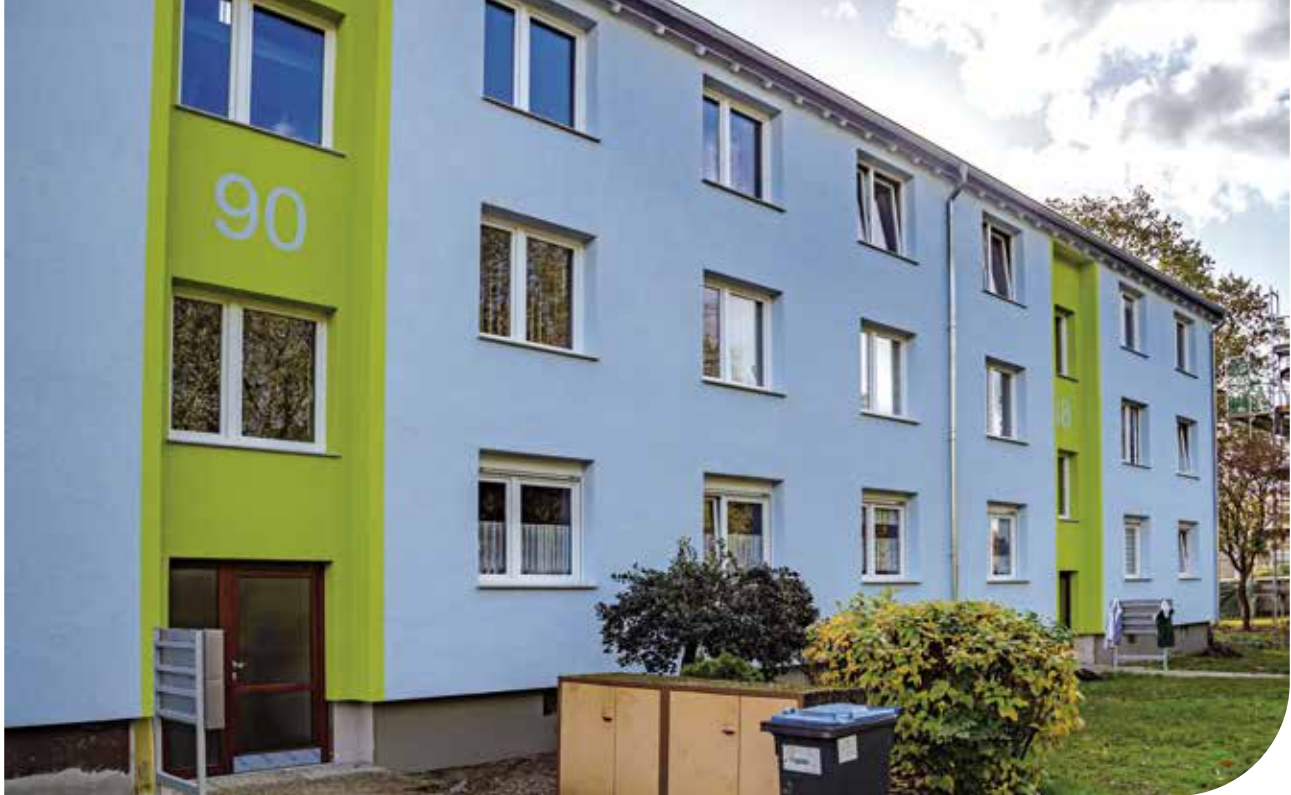
Während die Vorderfront der Häuser 88 und 90 fertig ist, wird an ....
